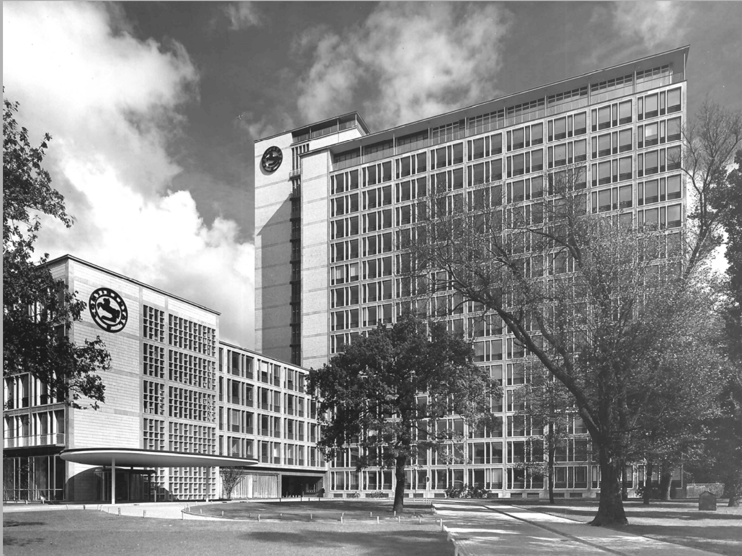
Hannover, Verwaltungsgebäude Continental AG, 1952/53 Königsworther Platz 1, Blick von Südosten, 1953
