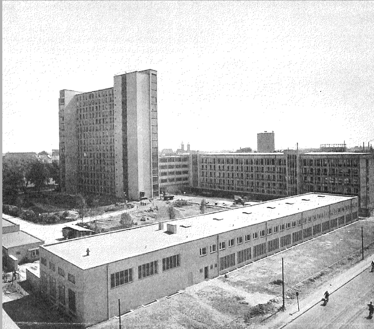
Hannover, Verwaltungsgebäude Continental AG, 1952/53 Königsworther Platz 1, Blick von Norden - im Vordergrund der Sozialtrakt -, 1953
