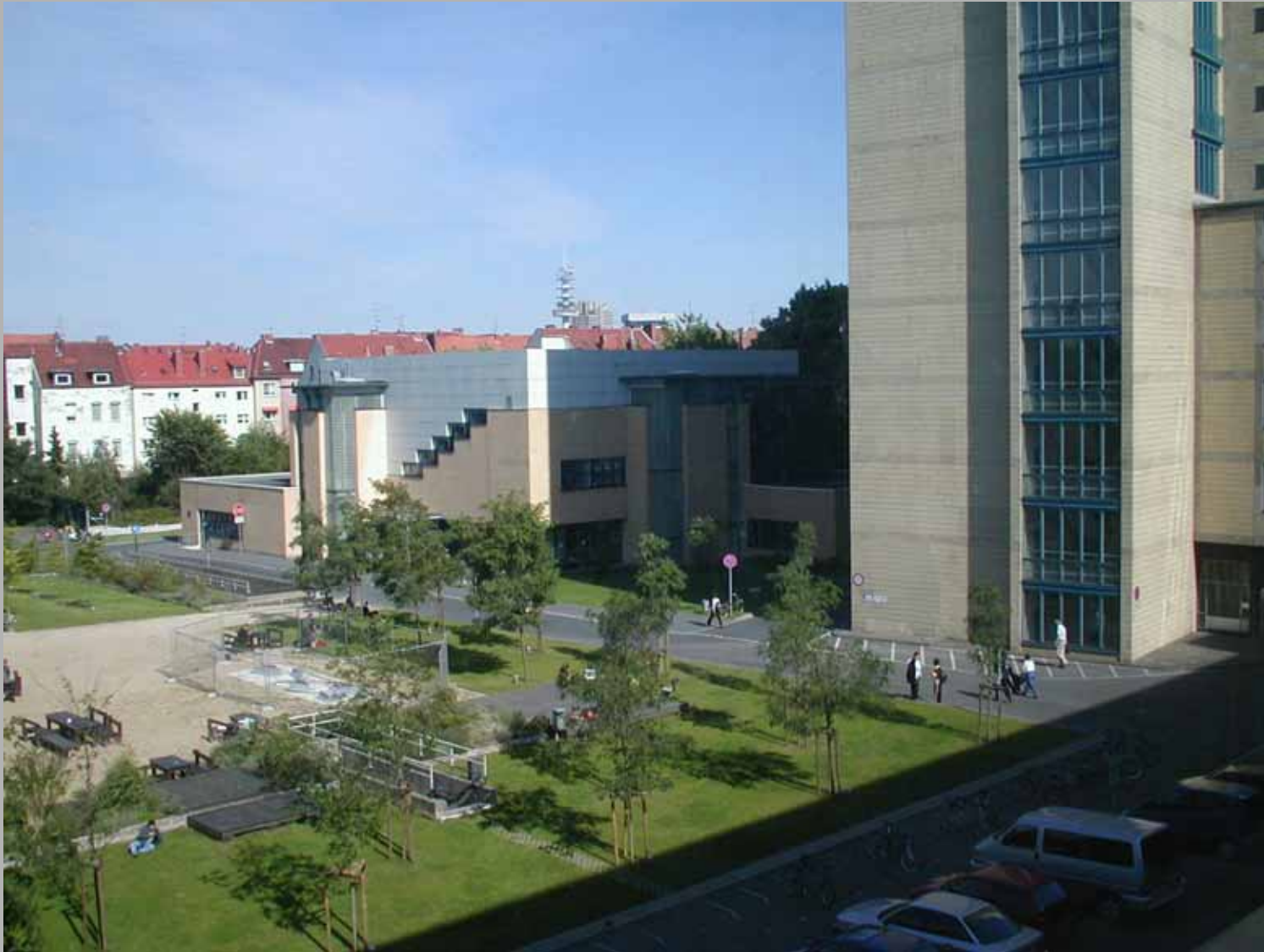
Hannover, Leibniz Universität, Hörsaalgebäude am Königsworther Platz 1, Blick von Osten - mit Anschnitt Hochhaus -, 1997
