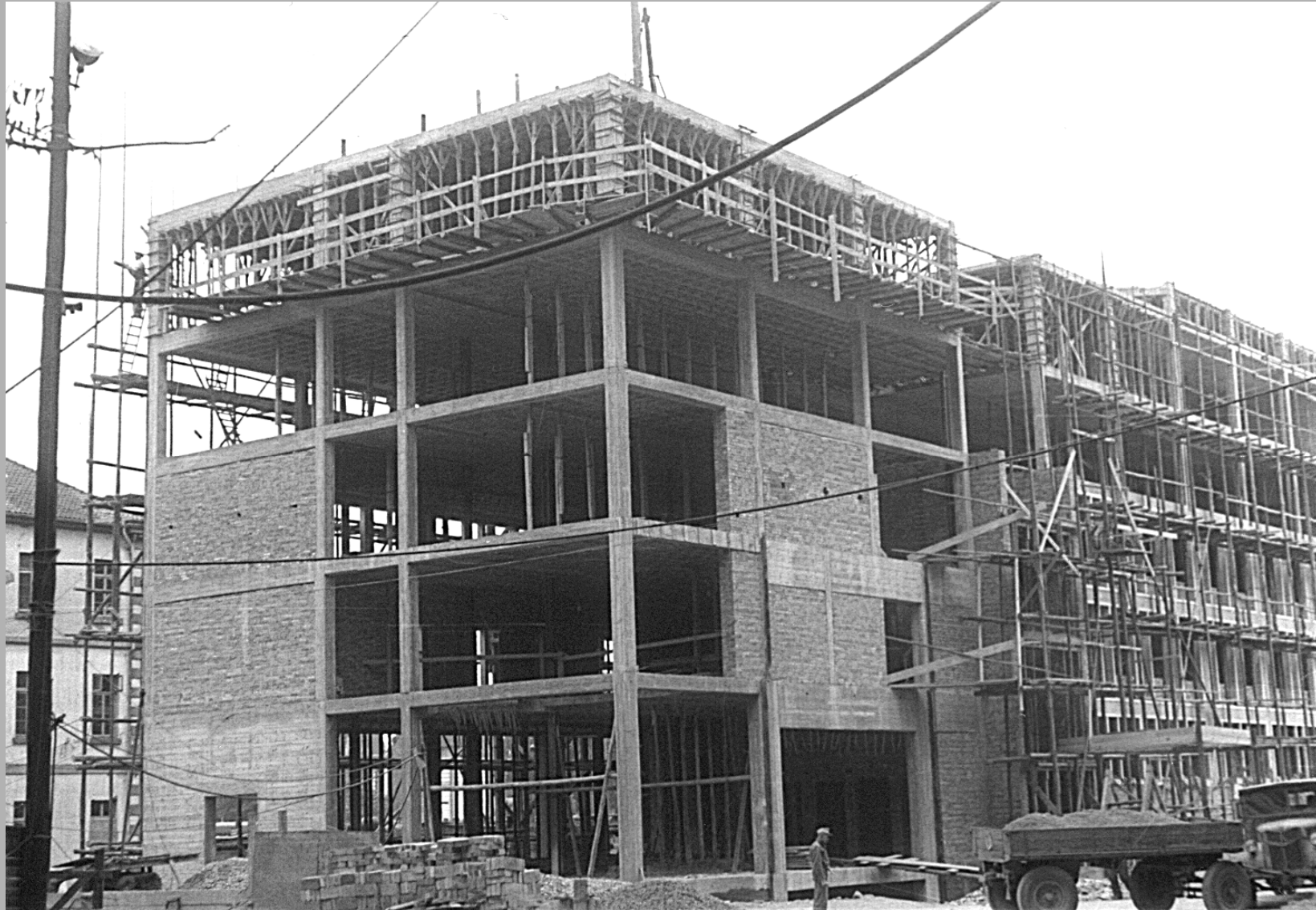
Hannover, Verwaltungsgebäude Continental AG, 1952/53 Königsworther Platz 1, Direktionstrakt im Rohbau, 1952
