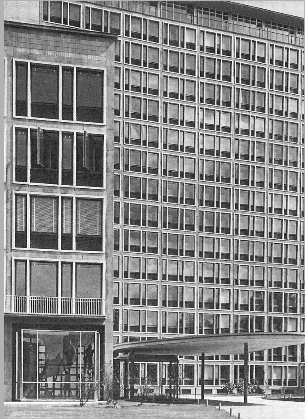
Hannover, Verwaltungsgebäude Continental AG, 1952/53 Königsworther Platz 1, Blick von Süden auf den Haupteingang, 1953
