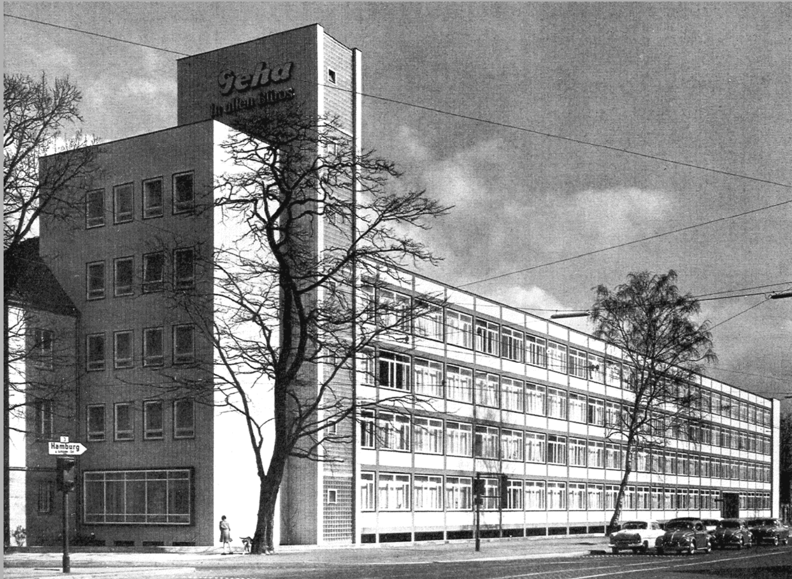
Hannover, Büro- u. Fabrikgebäude der Geha-Werke, 1955/56 Podbielskistraße 321, Blick von Südwesten, 1956
