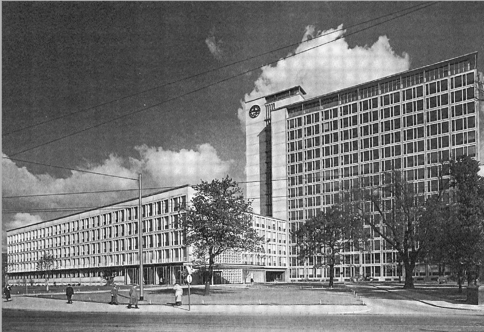
Hannover, Verwaltungsgebäude Continental AG, 1952/53 Königsworther Platz 1, Blick von Süden, 1953
