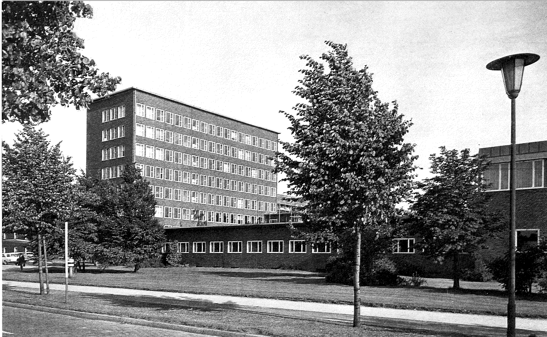
Hannover, Verwaltung und Zentrallabor der Kali-Chemie, 1950/51 Hans-Böckler-Allee 20, Blick von Westen, 1963
